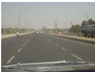
新たに建設された4車線道路
