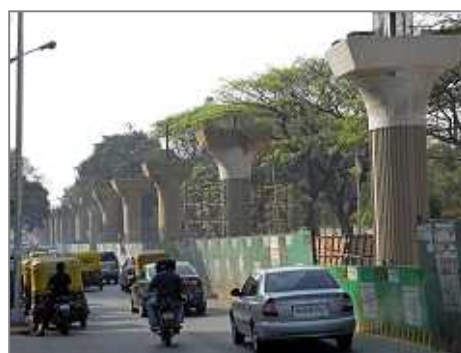
[バンガロール市内のメトロ高架工事]
