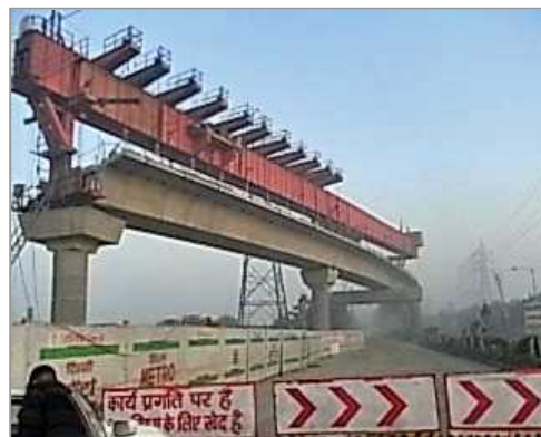
[グルガオンに延びるデリーメトロ工事現場]
