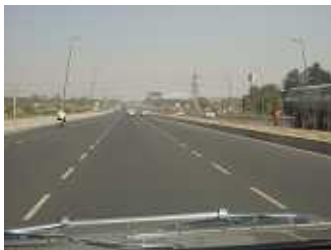
新たに建設された4車線道路
